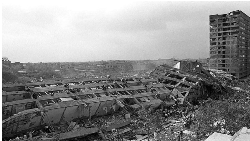
Figure 29 TEn 1985, el sismo en la ciudad de México provocó el derrumbe de varios edificios en Tlatelolco. En la imagen, el Nuevo LeónFoto Marco Antonio Cruz
